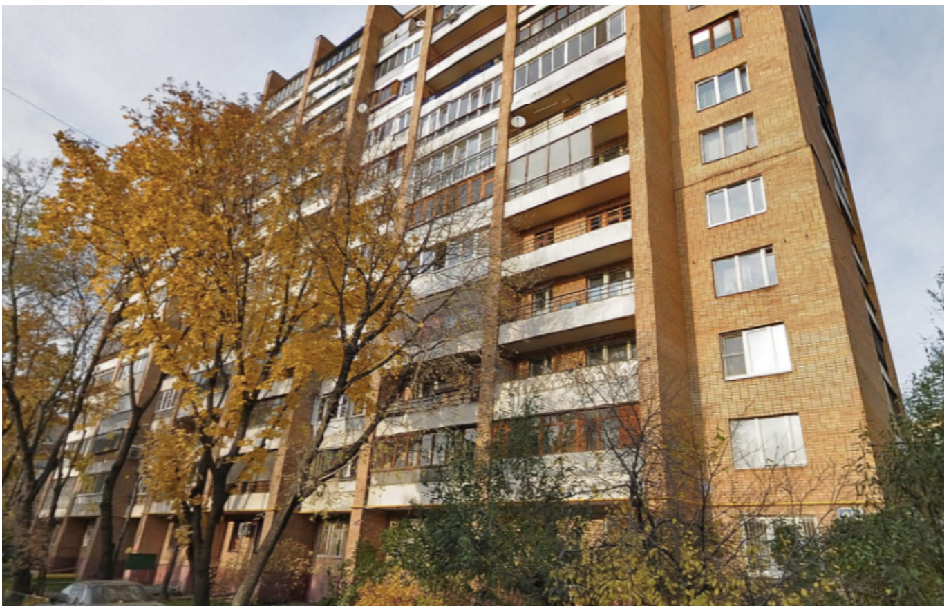
Рис. 1 Общий вид здания.
